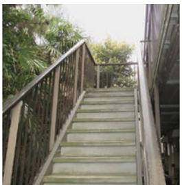
外廊下、外階段：押出成形セメント板
